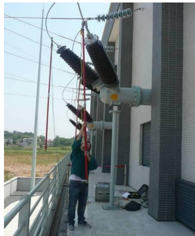
图 6-2：测试线通过绝缘棒引到被测线路上
