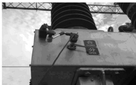
35KV SF6 开关传感器安装
