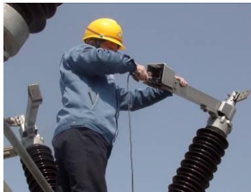
第三步 测量触指压力
