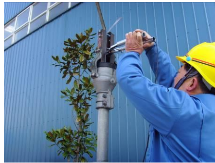
第三步 测量触指压力(未挂静触头)
