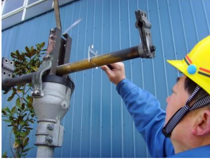
第一步 测量触头的宽度 a
