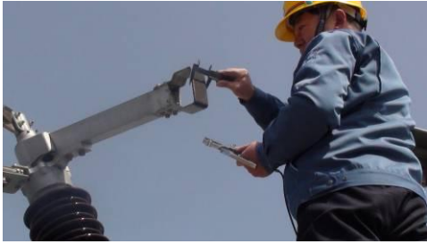
第一步 测量触头的宽度 a
