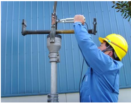
第三步 测量触指压力(已挂静触头，使测量头宽度略大于 a )
